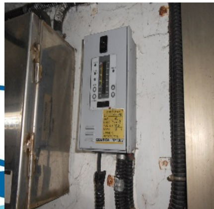
廢液暫存間設置危害 氣體偵測警報裝置
